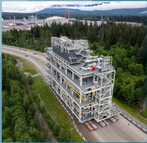
LNG Canada Site Module Delivery, Kitimat
