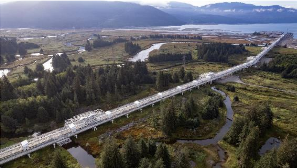
PHOTO 6: TRESTLE AND LNG LOADING LINES
