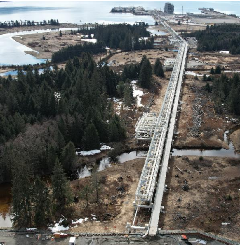
PHOTO 7: LNG LOADING LINE – TRESTLE (APRIL 02, 2023)
